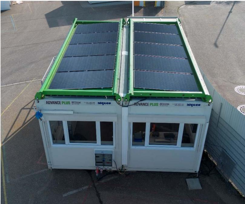
Algeco Solar liefert nachhaltigen Sonnenstrom direkt vom Dach eines Modulgebäudes. Das System ist schnell und einfach auf einem Container installiert und erzeugt danach bis zu 2.175 Watt Peak pro Einheit. Bildquelle: Algeco
